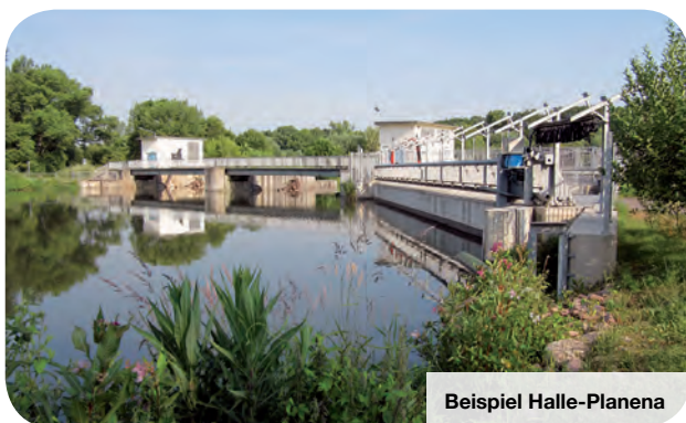
Abb. 1: Oberwasser mit Wehr und Fischabstiegsanlage.
