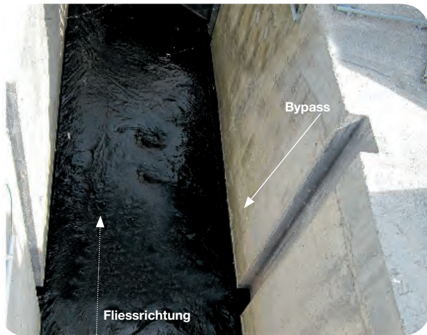
Abb. 6: Der Bypass kann bei Hochwasser geschlossen werden.
